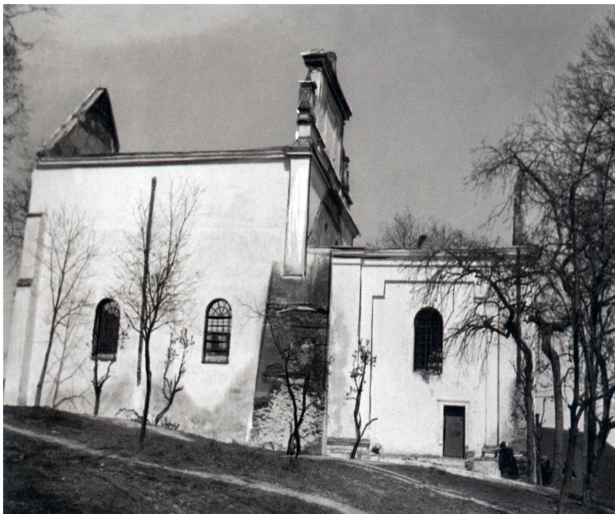
Częściowo rozebrana szczepresska cerkiew
