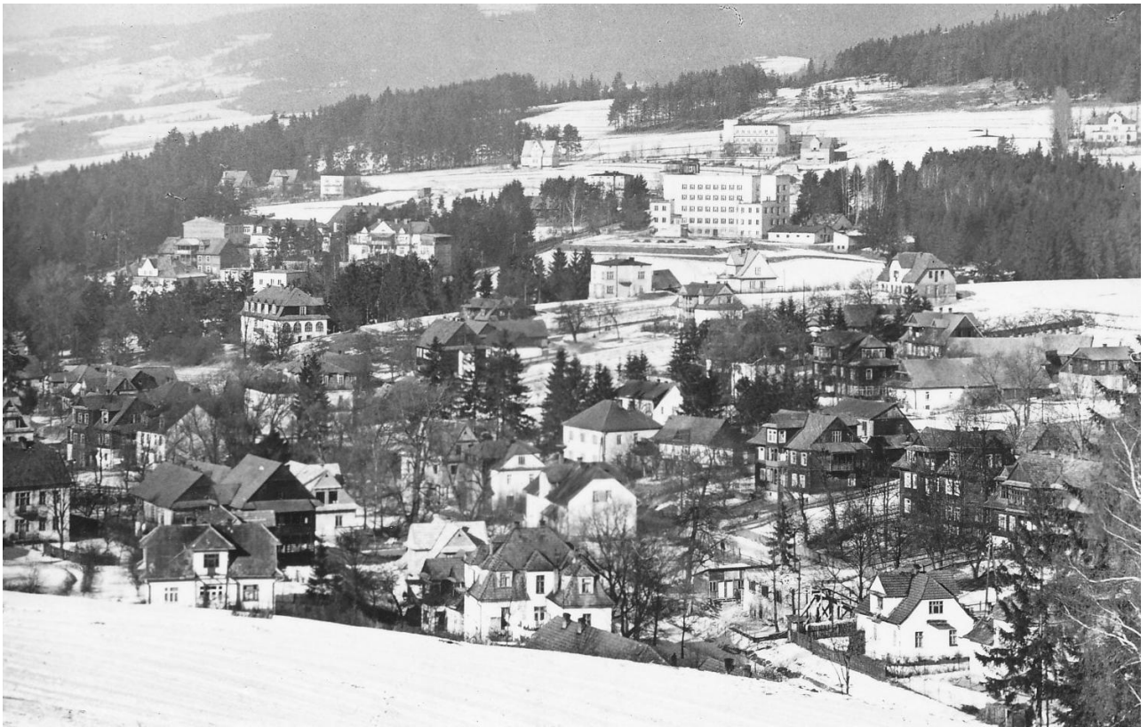
Rabka-Zdrój- 4-ro piętrowy gmach to Liceum Pedagogiczne
